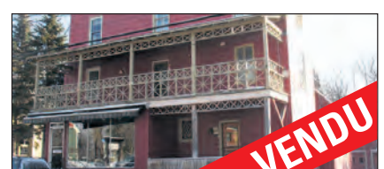
102-104 Lakeside: Bâtiment patrimonial au centre-ville de Knowlton. 3 étages: commercial et résidentiel. Ascenseur dans l'édifice.
