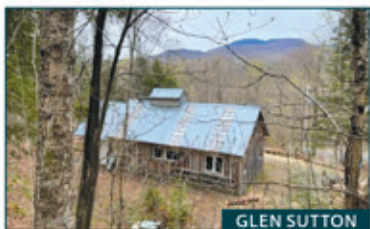
GLEN SUTTON Bienvenue à Glen Sutton. Érablière de 43 acres de terrain tout équipé avec un camp et un droit de construire une résidence. Investissez dans votre avenir. 670 000 $ John Boudreau
