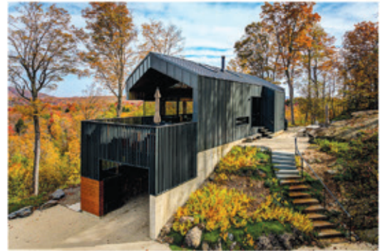
MAISON D'ARCHITECTE 1 645 000$*TX 120 rue des Sommets, Bolton-Est Centris #27816345
